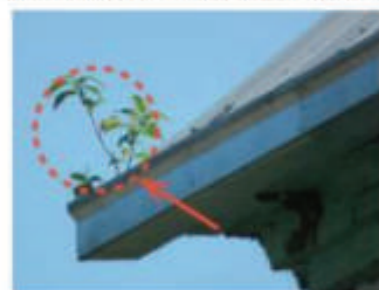
FF-2.1 Užnešti stogo lietoviai, juose auga augalai. Per užsinešusius lietovius vanduo negali tinkamai nutekėti, todėl vanduo bėga pro kraštus, tyška ant fasado, cokolio. Sudreklusios perteklinės sąnašos atlieka ilgiau todėl lietoviai dažniau būna pavirkti drėgmės, kuri paspartina koroziją. Galimos stogo konstrukcijų, fasado apdailos bei lietovių padalio (puvinys, surūdijimas).
