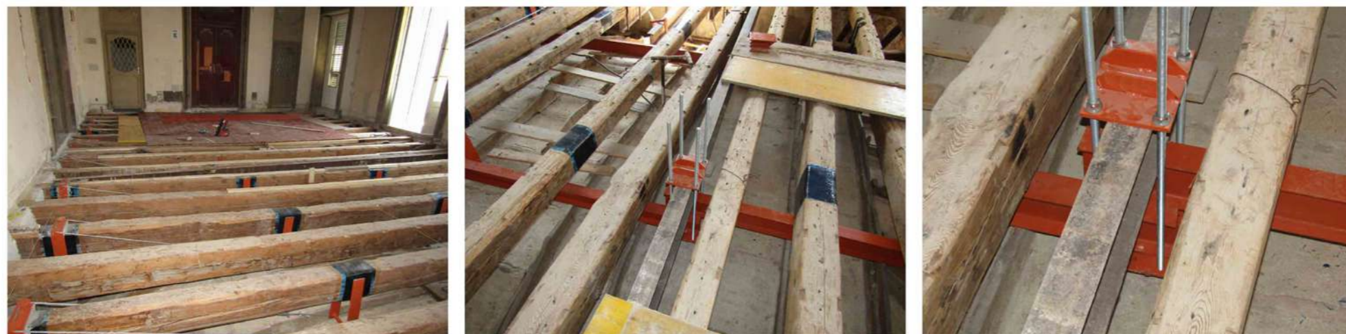
INTERVENTI SOLAIO GALLERIA SECONDO PIANO NOBILE
